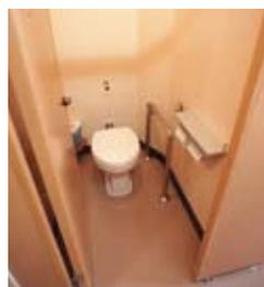
トイレ改修時に換気用のダクトをコーナーに設置した例。一見すると壁が斜めになっているだけに見えます。
