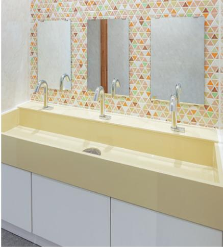
黄色のスクエア型洗面ボウル。トイレ内がより明るく感じられる。水栓はセンサー式の自動水栓が設置されている。
