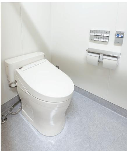
武道館のトイレに設置された温水洗浄便座と発電タイプの電波式リモコン。
