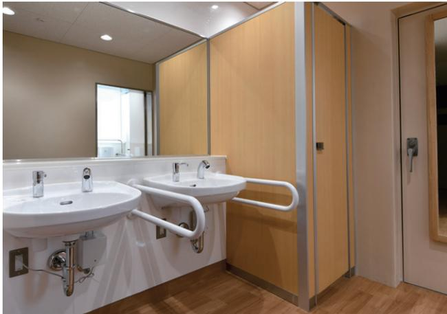
西舎1階男子トイレ。手洗いは自動水栓と水石けん供給栓。災害時や、けがをした生徒が困らないよう、各所に手すりを設置。
