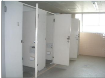
改修前のトイレ全体
