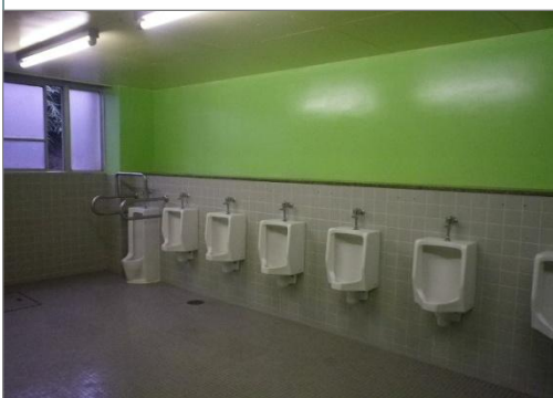
改修後、プロの清掃後の男子トイレ
