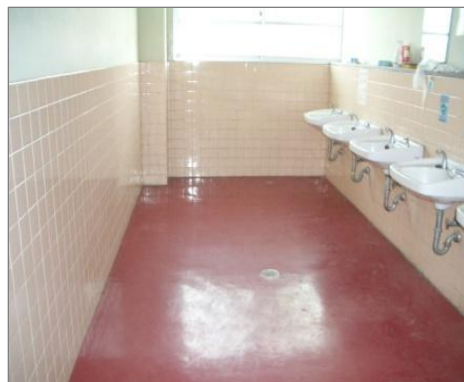
改修前の女子洗面コーナー
