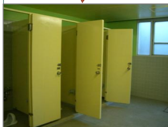
改修後のトイレ全体
